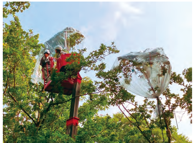
高所作業車による樹冠へのチャンバー設置の様子。
